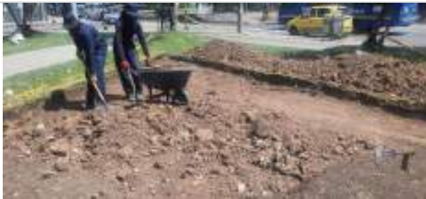
Imagen 2: Retiro del material de recebo
