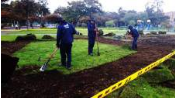
Imagen 1: descapote y remoción de terreno
