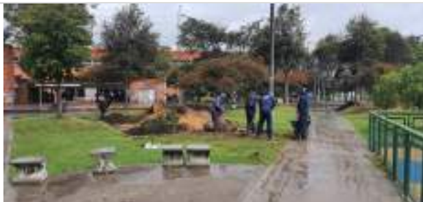
Imagen 3: Adecuación y abono del terreno
